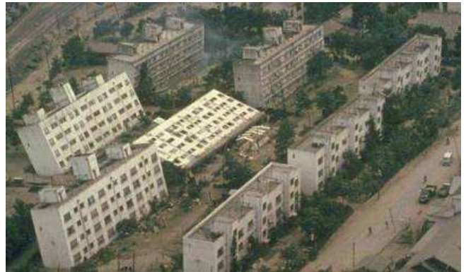
Lo que un terremoto puede hacer a los edificios construidos sobre suelos inapropiados.
