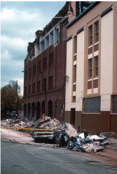
Murstein falt ned fra bygningen og knuste bilder og drepte fem personer som var på vei hjem fra jobb. Jordskjelvet i Loma Prieta, 17 Oktober 1989. (Fra US Geological Survey bildesamling: http://libraryphoto.cr.usgs.gov Slide 1-1 USGS Open File Report 90-547)
