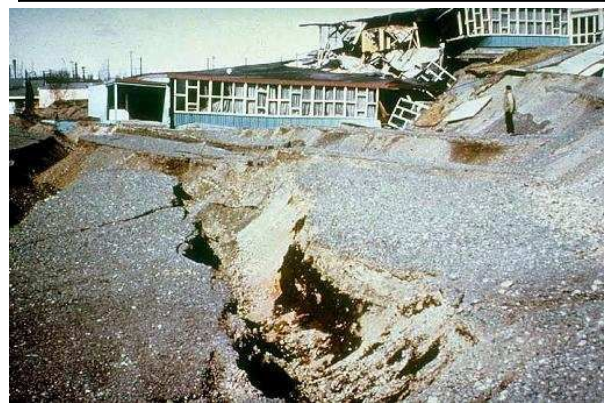
Under jordskjelvet i 1964 sank bakken inn og rev i stykker denne barneskolen. Legg merke til den store sprekken som også ble dannet under samme jordskjelv (jordskjelvet styrke var 9,2).
