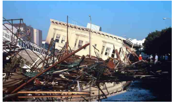
Kollaps og brann i bygninger i Marina District, San Francisco. Loma Prieta, California, Jordskjelv 17. oktober, 1989.
