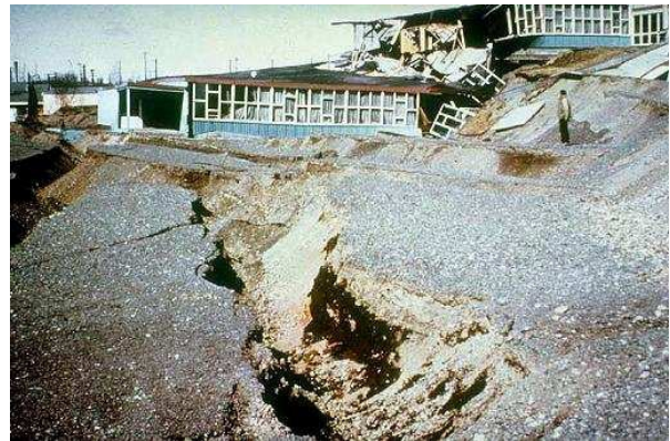
Scuola elementare governativa di Hill crollata a causa della subsidenza avvenuta durante il terremoto del 1964. Notare l'ampia crepa in primo piano causata anch'essa dal terremoto, (magnitudo 9.2).
