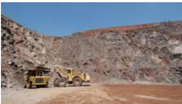
Interior de la Cantera de MQP's Cliff Hill en Leicestershire, GB
