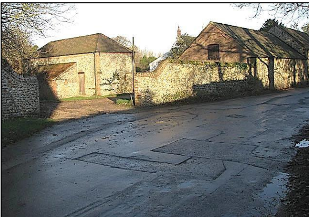
Camí reparat a una granja – quina capa es ve dipositar primer?
