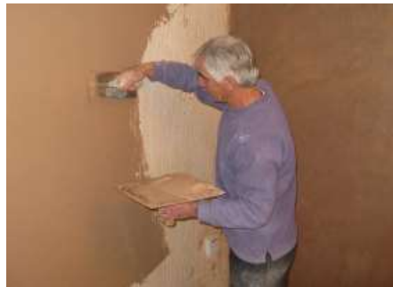
Un operari escaiolant una paret (Treball cedit al domini públic pel seu autor, Arpingstone )
