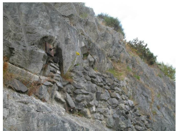
Figura 5. Bulloni da roccia e reti utilizzate per stabilizzare le rocce su un pendio nel taglio di Ty Nant lungo la A5, nel Galles del Nord.
