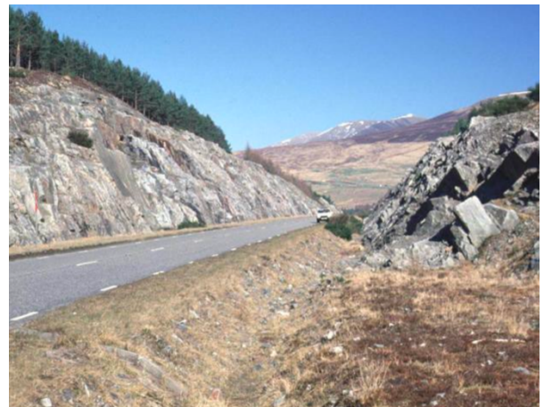
Figura 4. Una strada che attraversa rocce inclinate da destra a sinistra. Le rocce sulla destra potrebbero facilmente scivolare lungo il piano di stratificazione, mentre quelle sulla sinistra sono relativamente stabili poiché sono inclinate verso il versante della collina.
