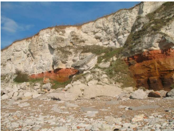
Figura 1. Crollo di blocchi di roccia calcarea caduti dalla sommità della parete rocciosa, Hunstanton, Norfolk, Regno Unito.
