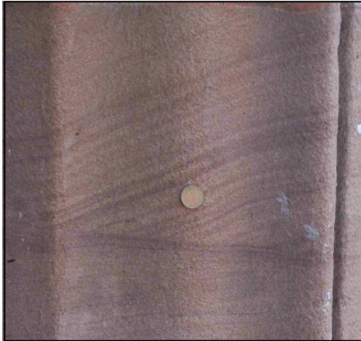
Foto 4: Arenisca roja de la fachada de un edificio (Moneda = 2cm) (Foto: Peter Kennett)
