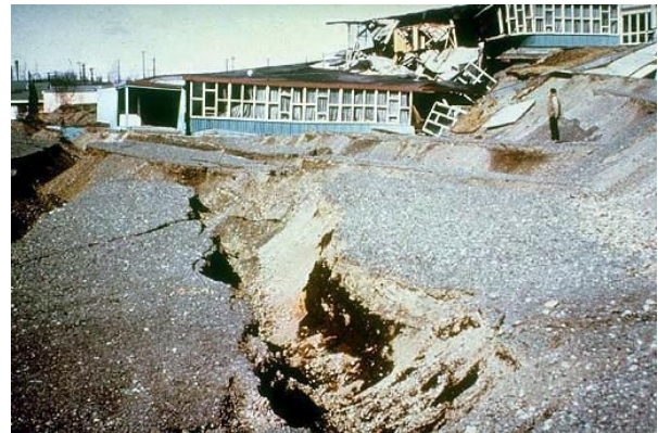
L'Escola Elemental de Hill "esquinçada" per la subsidència que es va produir durant el terratrèmol de 1964. Observeu l'enorme esquerda del primer pla causada també el terratrèmol de 9.2 graus de magnitud.
