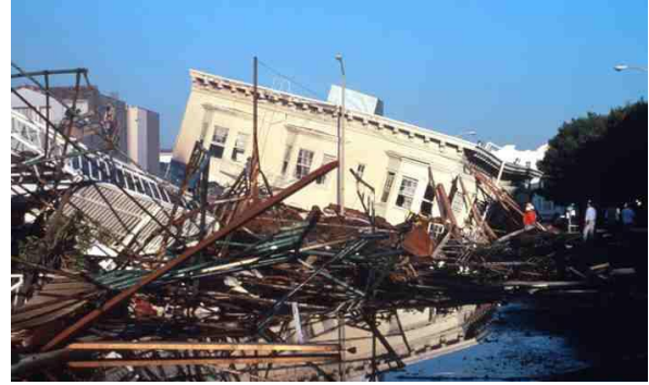
Edificis col·lapsats i cremats al districte del port, San Francisco. Terratrèmol de Loma Prieta, Califòrnia, 17 d'octubre de 1989.
