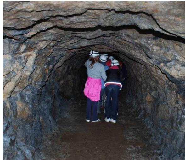
Túnel sin apoyo excavado en calizas por mineros del cobre en 1804 (Todas las fotos: *Peter Kennett*)
