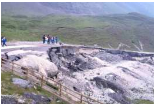
Mam Tor – la antigua carretera, ahora inutilizada por el deslizamiento de 1977. (Fotos: Peter Kennett)
