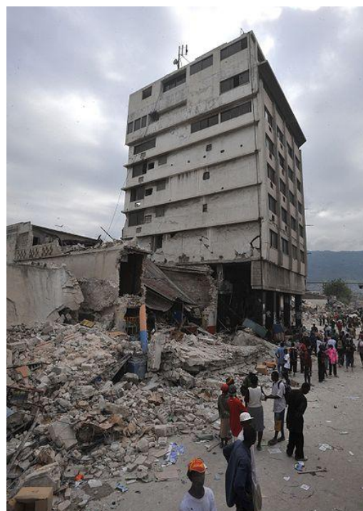
Edificis danyats al barri de Bel-Air a Port-au-Prince, després del terratrèmol d'Haití de 2010. L'edifici alt es manté en peu entre les runes d'altres edificis més baixos mal construïts.
