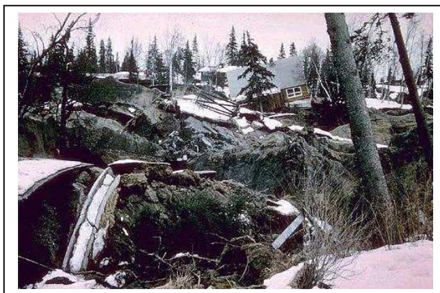
Edificios arrastrados por un deslizamiento. El deslizamiento de Turnagain Heights en Anchorage (Alaska). 75 casas se hundieron, giraron o colapsaron cuando la liquefacción del subsuelo produjo el desplazamiento de un área urbano por más de 700m durante el terremoto de 1964, que alcanzó una magnitud 9.2.
