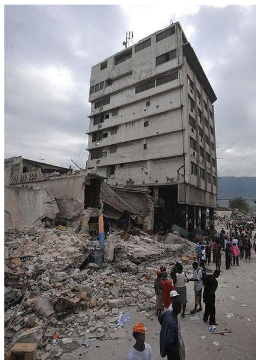
Edificios dañados en el barrio de Bel-Air en Port-au-Prince, después del terremoto de Haití de 2010. El edificio alto se mantiene en pie entre las ruinas de otros edificios más bajos mal contruidos.
